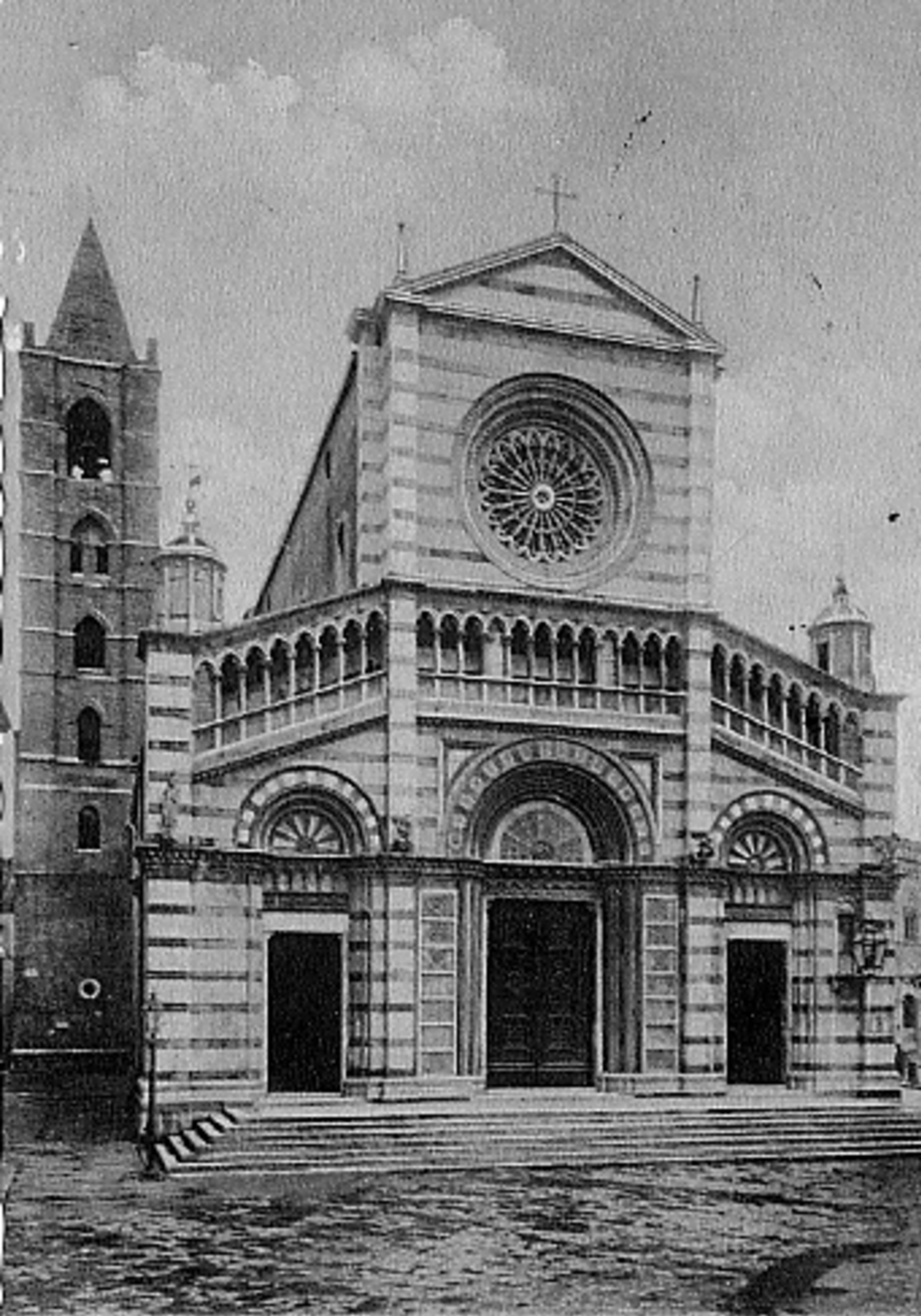
Grosseto - Cattedrale La Facciata (Sozzo Rustichini, XIII secolo)
